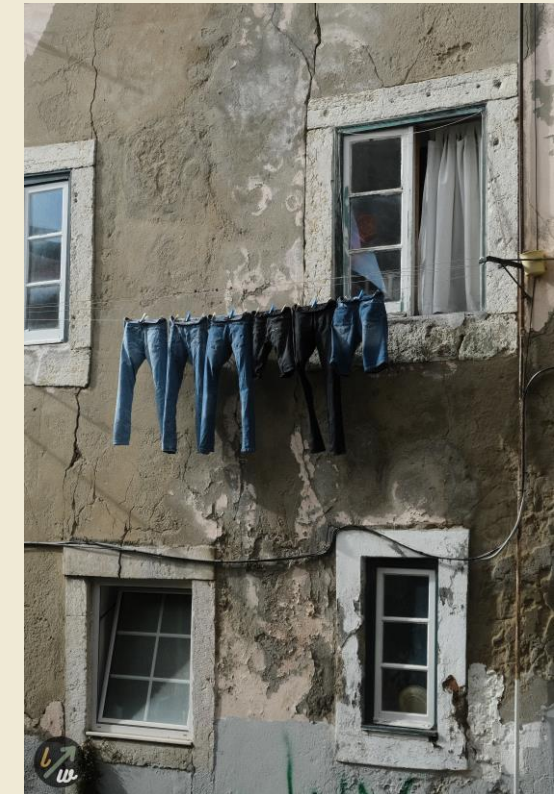
Frische Wäsche, alte Wände
